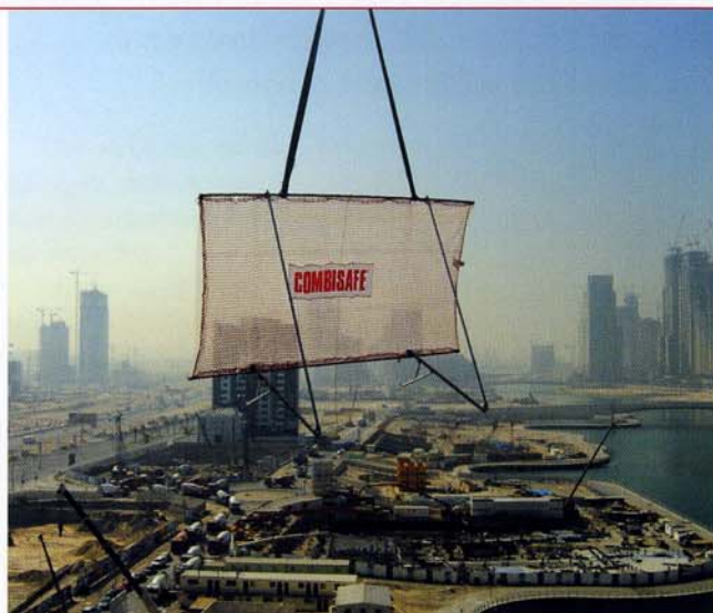
Der Combisafe Safety Net Fan: das effiziente Fallschutzsystem für Arbeitskräfte und herabstürzende Gegenstände
